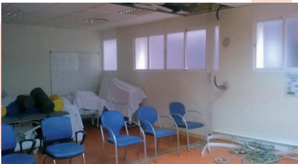
Ampliación de la sala de entrenamiento. Agosto 2015
